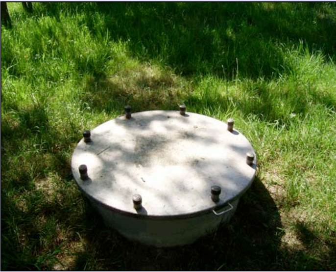
Bild 35: Unter diesem Deckel befindet sich ein Brunnenschacht. Hier wird das Mineralwasser an die Oberfläche befördert.
