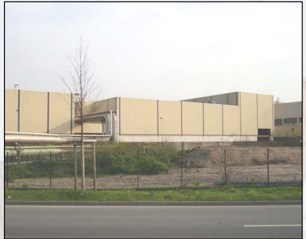
Bild 37: Durch den Bau von Industrieanlagen und Straßen ist der Boden versiegelt.
